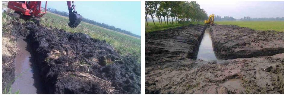
Gambar 15. Proses Pembuatan Saluran Drainase dengan Backhoe
